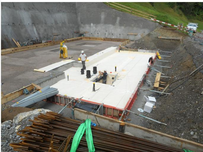
Folienauskleidung des Vorraums vor dem Betonieren
