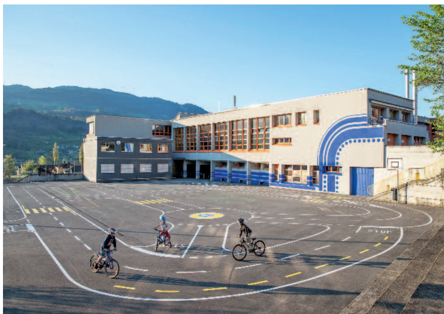
Im Verkehrsgarten kann in geschütztem Rahmen das Verhalten auf der Strasse geübt werden.
