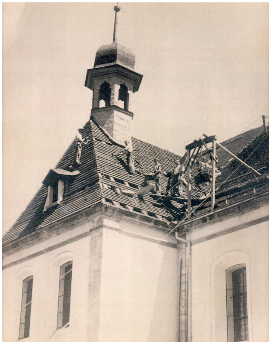
Im Jahr 1939 wurden am Dach der Pfarrkirche für 16'512 Franken Renovationsarbeiten ausgeführt. Auf unserem Bild sind die einheimischen Dachdecker Franz von Ah (dritter von rechts) und sein Sohn Ernst von Ah (zweiter von rechts) zu erkennen.
