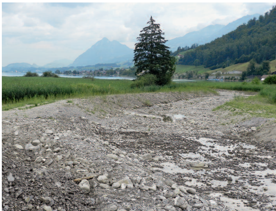
Die Kleine Melchaa wird auf Sachslers Gemeindegebiet in einem neuen Gerinne in den Sarnersee münden. Die Abschlussarbeiten erfolgen nach den Sommerferien.
