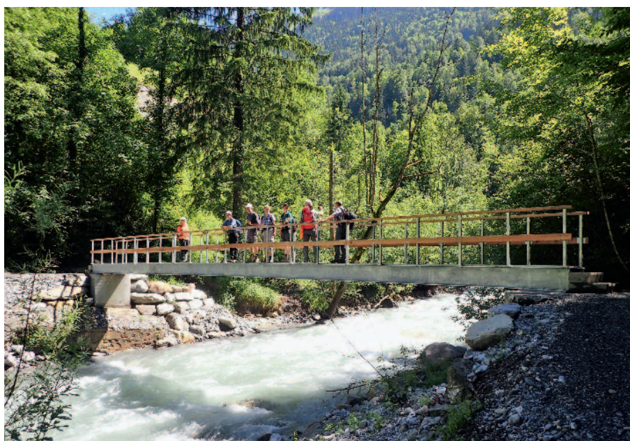
Der wieder geöffnete Wanderweg überquert die Melchaa 1,5 Meter über dem Wasserspiegel auf einer neuen Stahlbrücke mit 19 Metern Spannweite.
