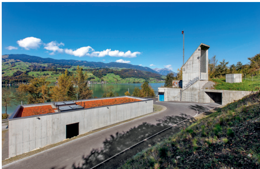
Neues Lüftungsgebäude (Portal Süd)
