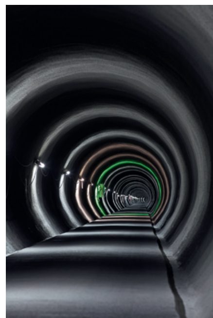
Neu erstellter Sicherheitsstollen
