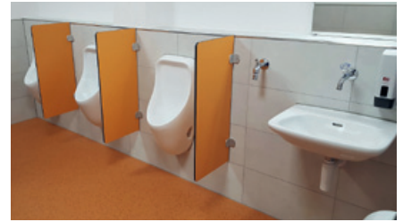
Die sanierten WC-Anlagen präsentieren sich mit einer freundlichen und frischen Farbgebung.
