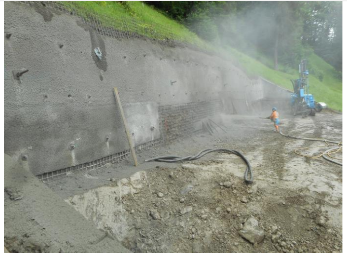
Stand der Arbeiten am 22. Juni 2022
