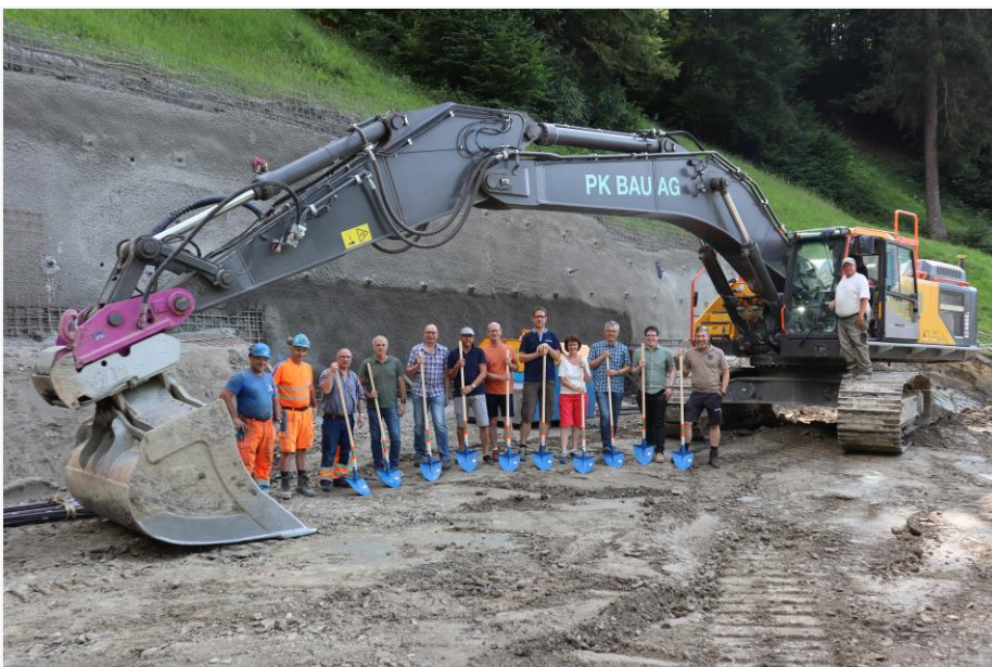
Der Bezirksrat der Wasserversorgung Sachseln zusammen mit Vertretern der ausführenden Unternehmungen und des Planers beim Spatenstich
