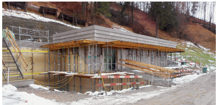
21. Dezember 2023: Einwinterung des Rohbaus.
