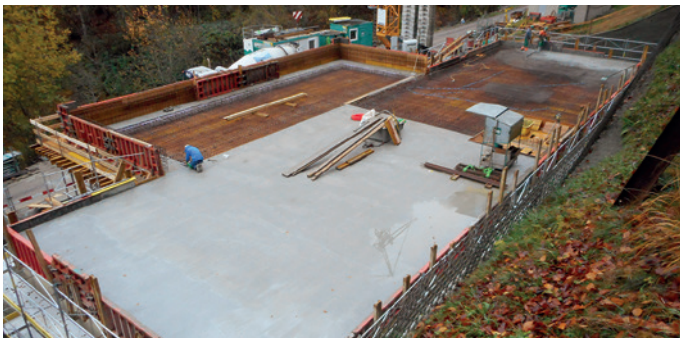
Ende November wurde die erste Etappe der Deckenplatte betoniert.
