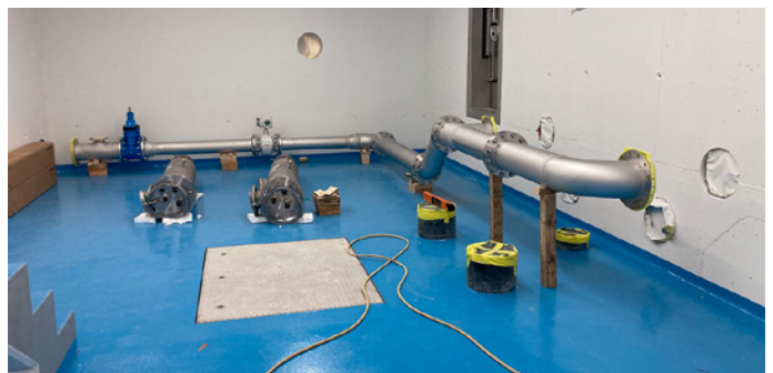
Verrohrung im Rohrkeller Anfang März 2023.
