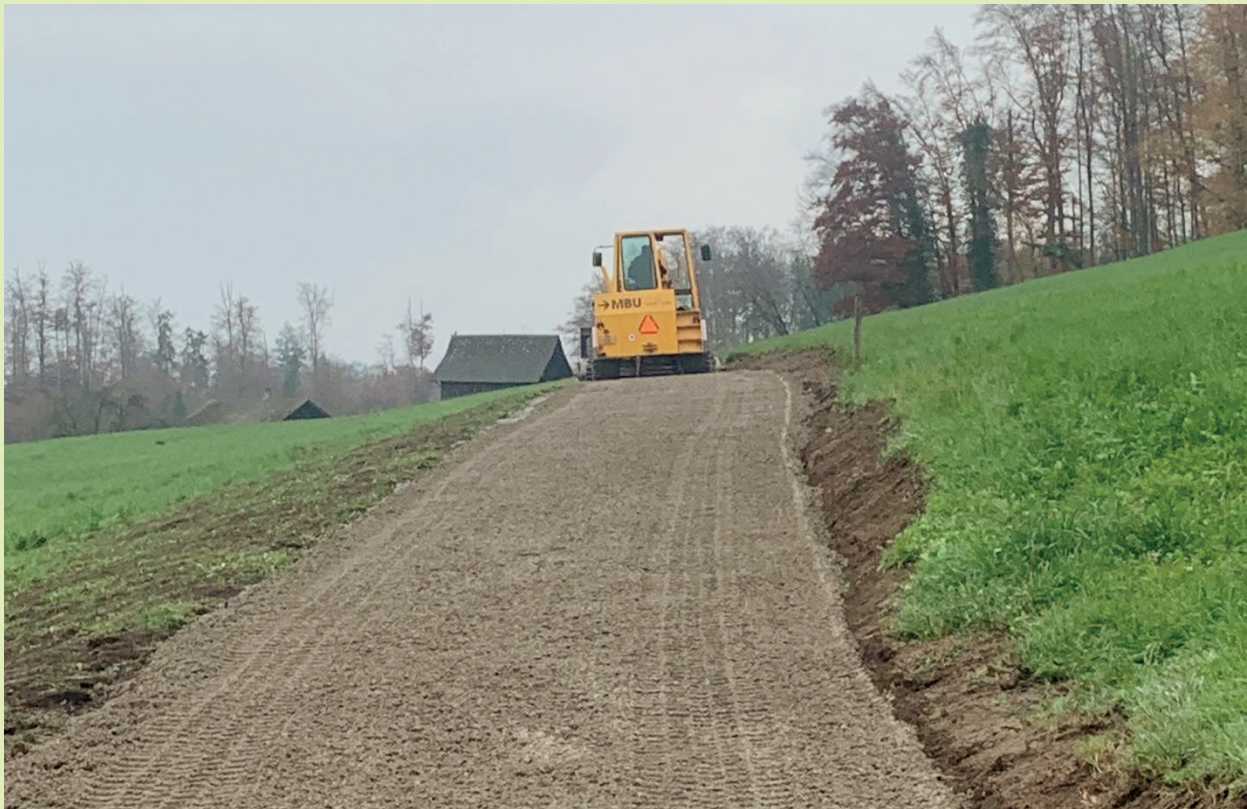
Sanierung der Allmendstrasse Ob Hohflue
