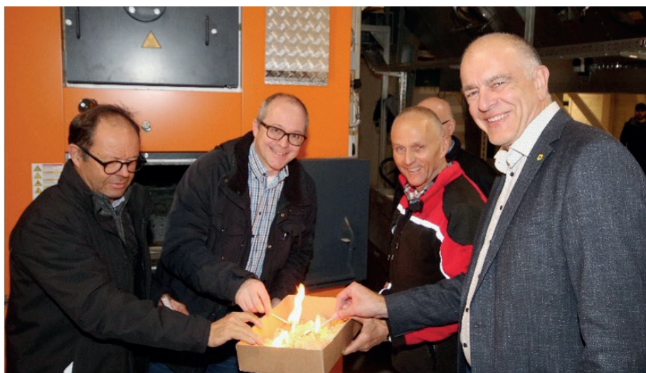
Feierliches Anfeuern des grossen Heizkessels durch Regierungsrat: Dr. Josef Hess, Kantonsratspräsident Dominik Rohrer, Korporationsratspräsident und Verwaltungsratspräsident Christian Rohrer (verdeckt), Förster Walter Berchtold und Gemeindepräsident Knut Hackbarth (von links nach rechts)
