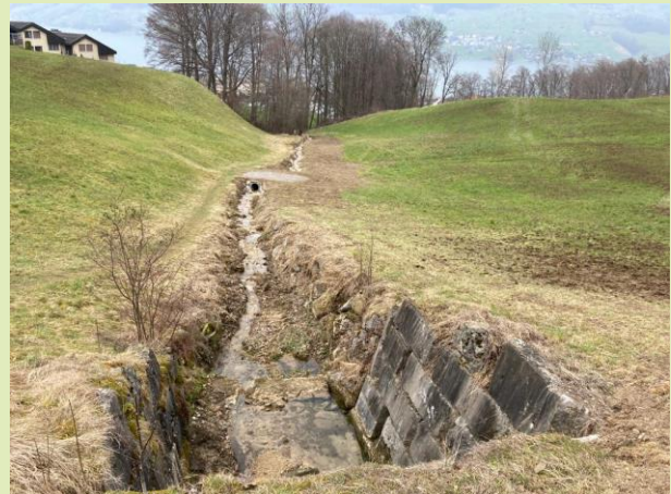
Gerinne Schwerzbach nach der Instandsetzung
